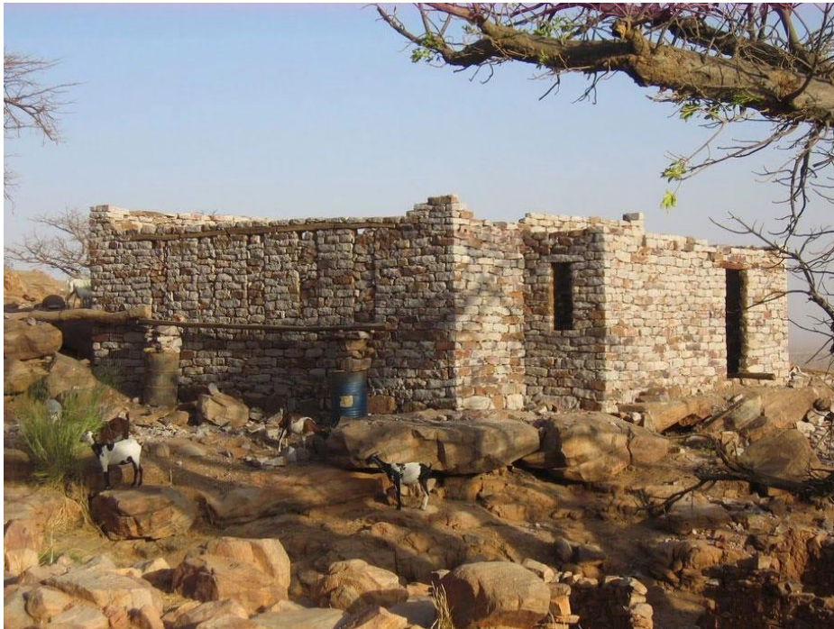
Construction des murs en pierre avec son échafaudage. ©dompalatchi ©dr ©anthropo
