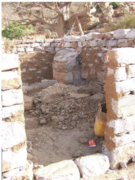
Le chantier. ©dompalatchi
